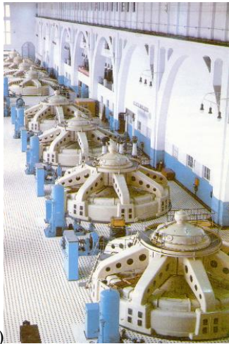
Рисунок 2.35. а) - Фото машинного зала ГЭС с синхронными генераторами; б) - Фото машинного зала ТЭС с одним энергоблоком с синхронным генератором и паровой турбиной
